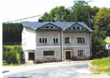
Bytový dům s pozemkem, Mostek
