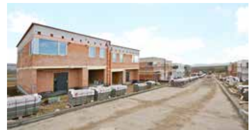
Novostavby RD 4+kk – stav ke dni 12. listopadu 2019
